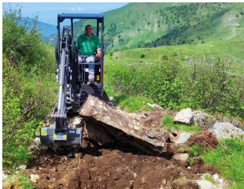
Necessario in alcuni tratti l'intervento degli scavatori.
