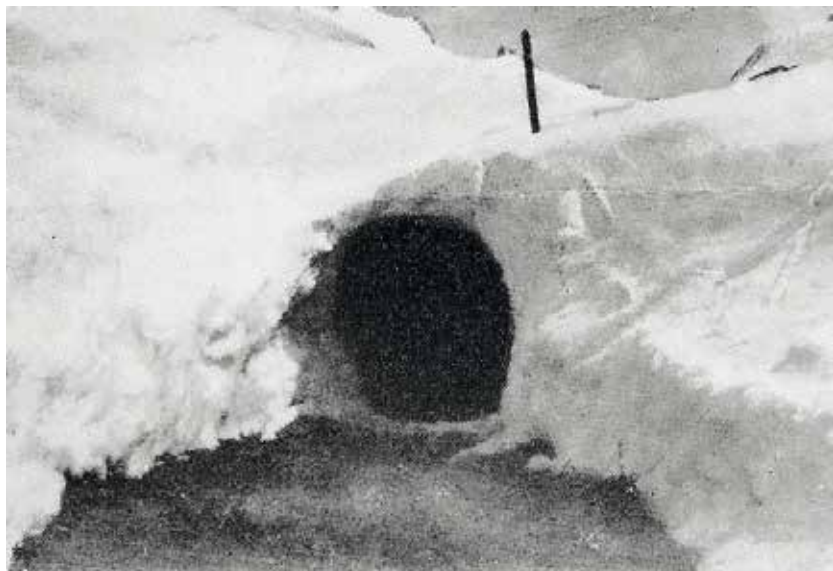
L'imbocco della galleria al Passo Garibaldi.
