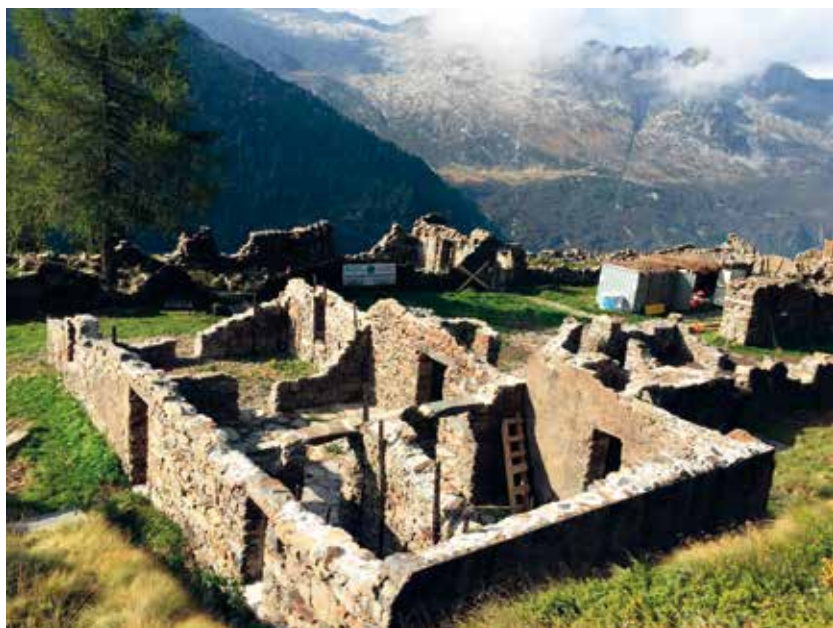
Caserma Campellio: Ben visibili gli interventi di pulizia e di avvio del recupero del manufatto svoltisi nei mesi estivi del 2015-2016.
