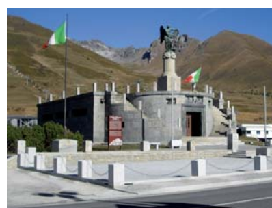
Passo del Tonale: Il Sacrario dopo gli interventi di pavimentazione dell'area antistante
