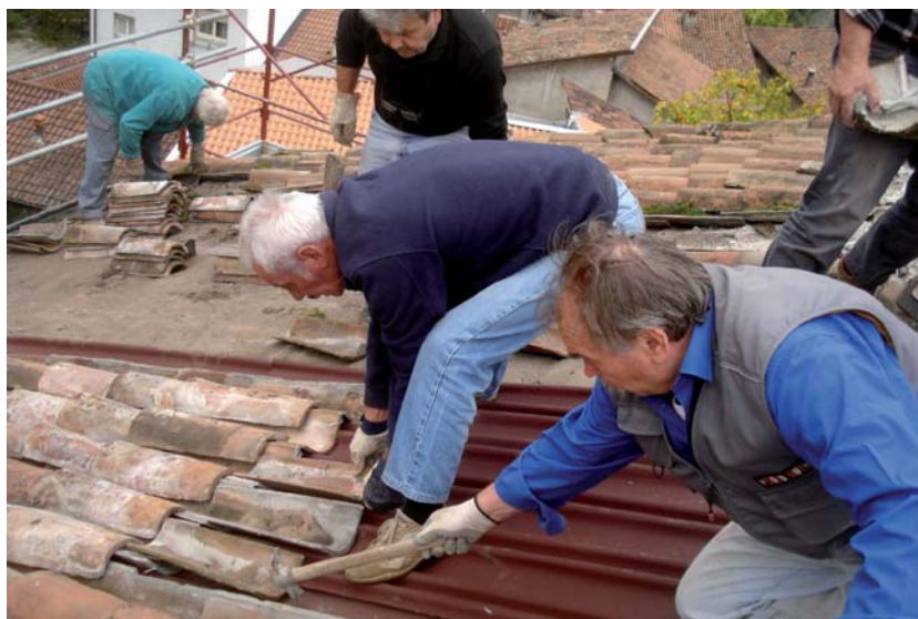
Civate Camuno: Alpini al lavoro per impermeabilizzare il tetto della chiesa di S. Stefano
