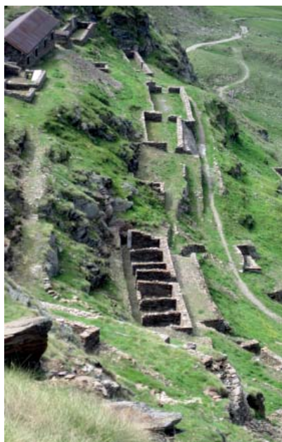
Una veduta dei lavori di ripristino di trincee e camminamenti al Montozzo.
