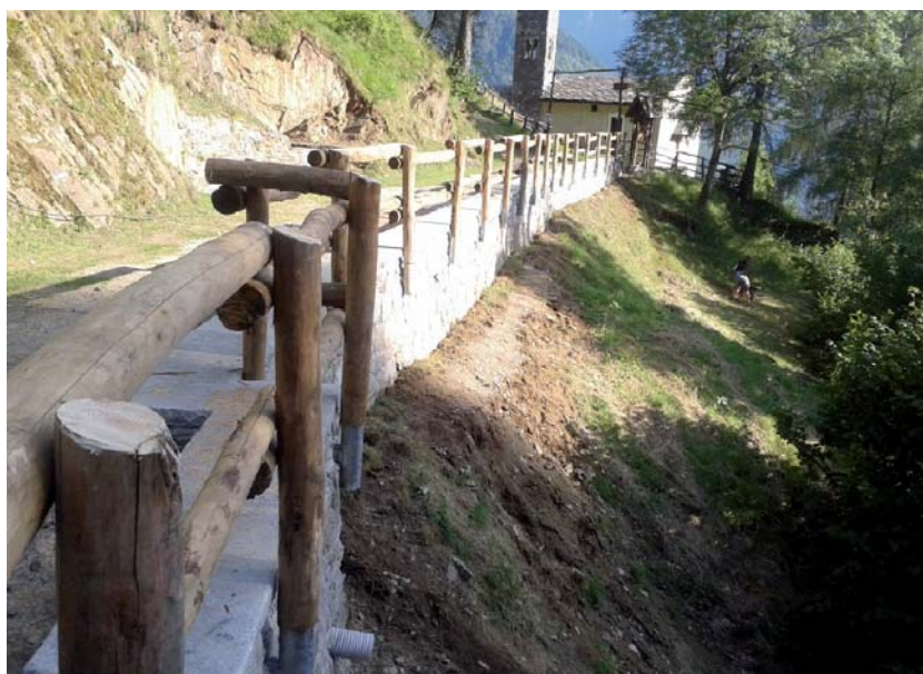
Il muro e la palizzata rifatti durante i lavori per mettere in sicurezza la strada.
