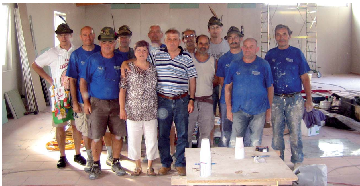
Alpini e volontari con il sindaco di Fossa all'interno della struttura in fase di realizzazione.
